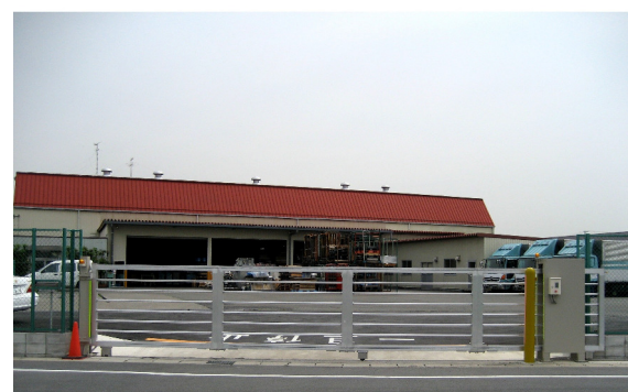
トラックゲート
